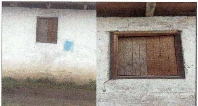
Foto 10: Estados de ventanas, cambiar ventanas de madera a metal.
