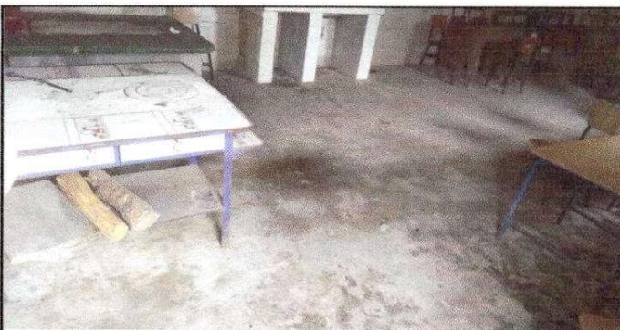
Foto 11: Piso de cocina torta de concreto, por facilitar limpieza se hace colocación de piso cerámico.
