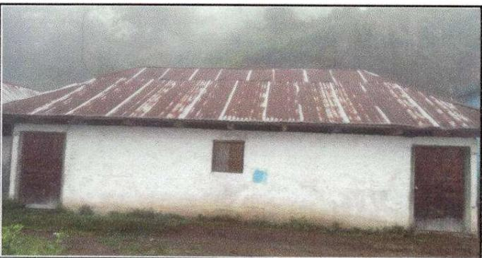
Foto 5: Techo en mal estado y oxidado. (Cocina)
